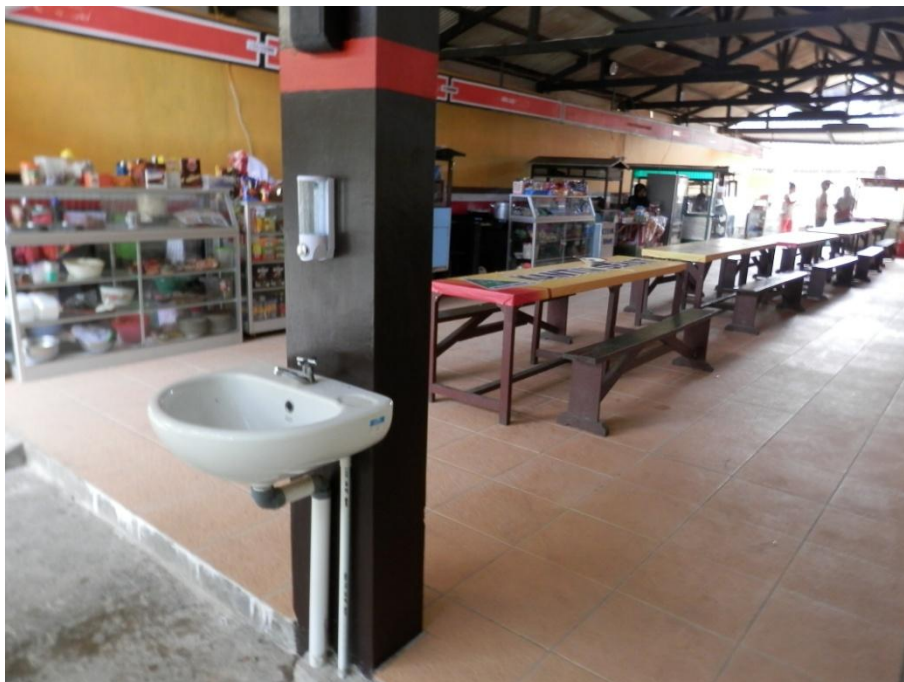
WASTAFEL DI DEPAN KANTIN
